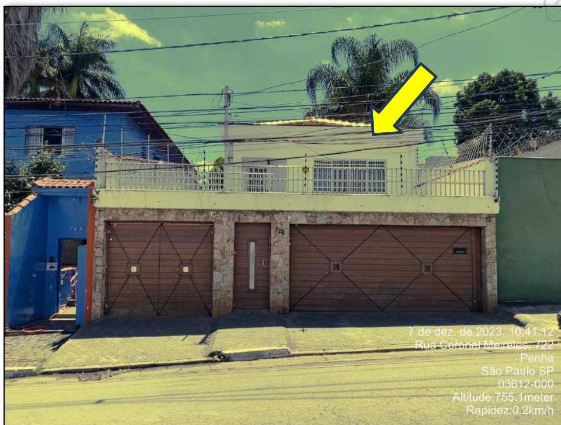
Fachada do IA - Imóvel Avaliando
